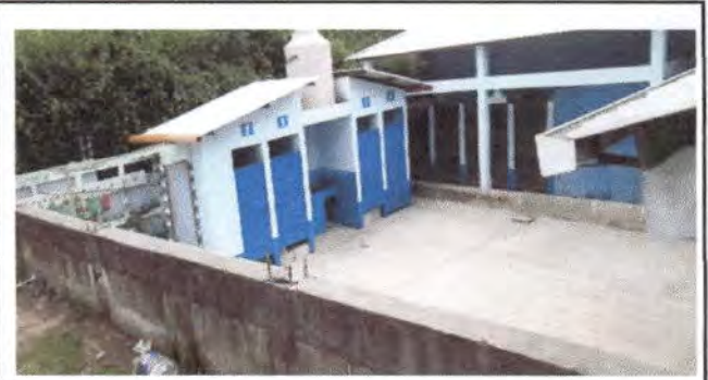
Foto 4: Instalación de depósito de agua finalizado enfrente de las aulas de quinto y tercero primaria de la escuela.
