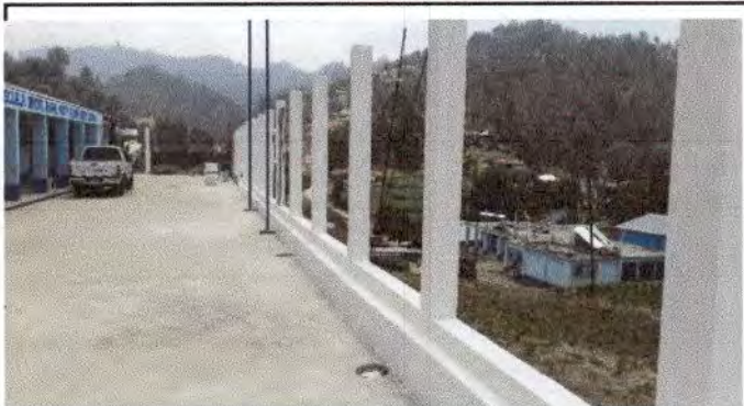
Foto 3: Construcción de solera de humedad y columnas para el soporte de los barrotes en la escuela.
