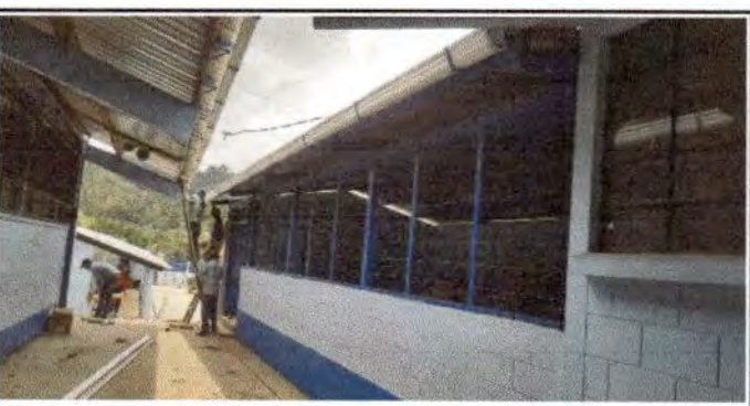
Foto 6. inslatción finalizada de canales enfrente del comedor y las aulas.
