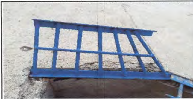
Foto 3: Instalación de rejilla en la salida del agua del patio del Centro Educativo.
