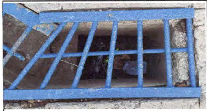
Foto 4: Instalación de rejilla para evitar accidentes de los estudiantes.
