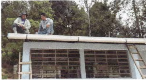
Foto 1: Instalación finalizada de canales de agua enfrente de las aulas de segundo y preprimaria.
