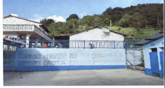
Foto 2: Instalación de baranda por el peligro que están expuestos los niños y niñas del Centro Educativo
