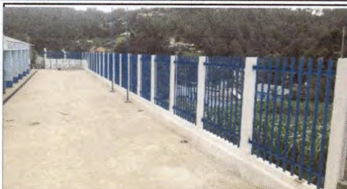
Foto1: Vista desde la parte de arriba de la construcción de barrotes de metal color azul cielo.
