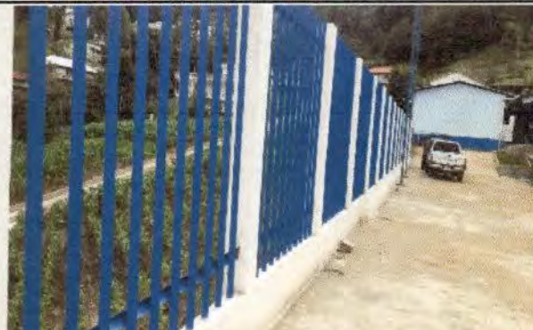
Foto 4: Instalación de barrotes de metal enfrente de la escuela color azul cielo.
