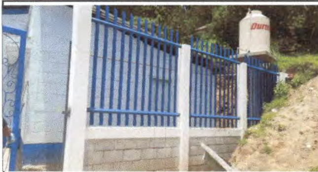
Foto 3: Instalación finalizada de barrotes a un lado de la cocina.
