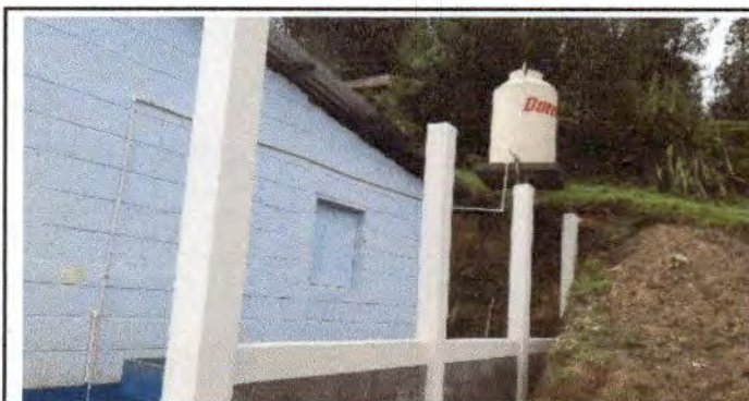
Foto 5: instalación de columnas al ingreso del centro educativo.
