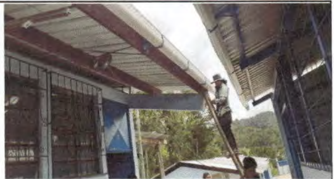
Foto 2: Instalación finalizada de canales de agua enfrente de las aulas de sexto y primero A de la escuela.
