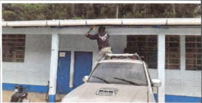
Foto 6: Vista final de la colocación de canal de agua enfrente de las aulas de segundo primaria y párvulos sección A.
