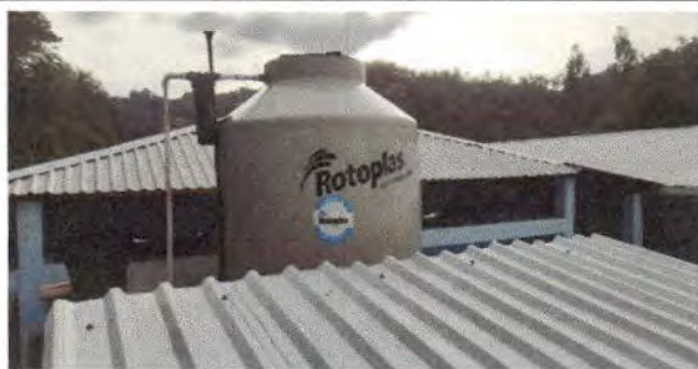
Foto 5: Instalación final del depósito de agua vista de la parte de arriba de las aulas.
