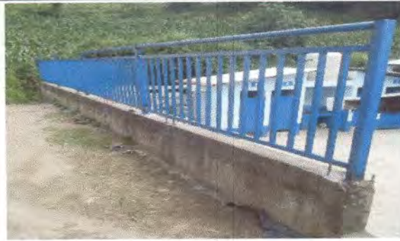
Foto 1: Baranda instalada en el lado oriente del centro educativo.
