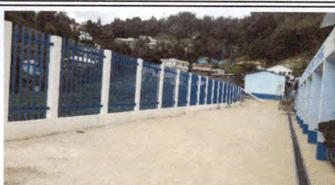
Foto 2: Instalación de barrotes desde el ingreso del centro educativo.
