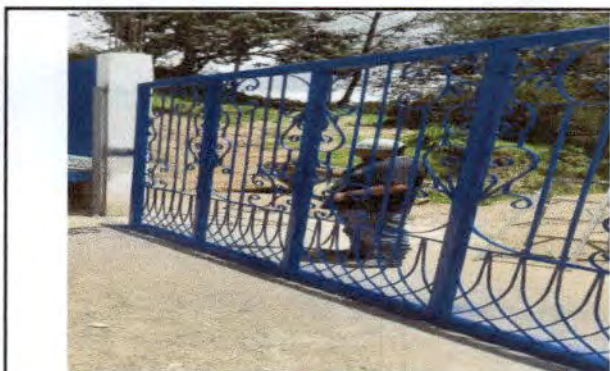
Foto 3: Verificando la instalacion de porton de metal de ingreso al Centro Educativo.
