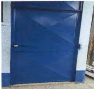
Foto 1: Instalación de puerta.
