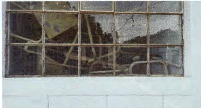
Foto 2: Instalación de vidrios en las diferentes aulas de la escuela.
